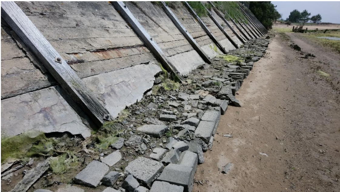
Digue maritime béton AVANT APRES
